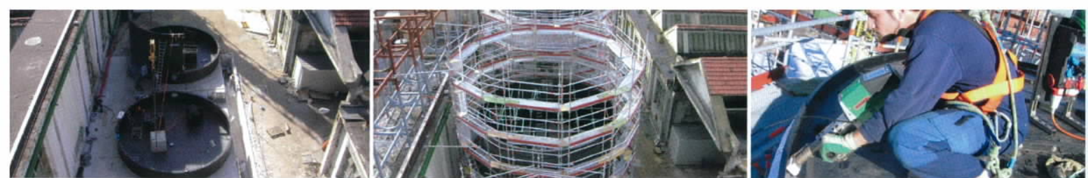
Abb. v.l.n.r.: Baubeginn, fortgeschrittener Bauabschnitt, Verbindung von Dach- mit Wandelementen
